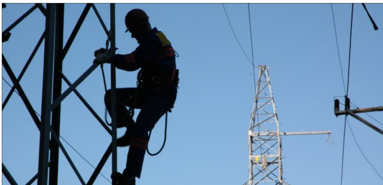
Подъем на металлоконструкцию с использованием стропа с амортизатором
