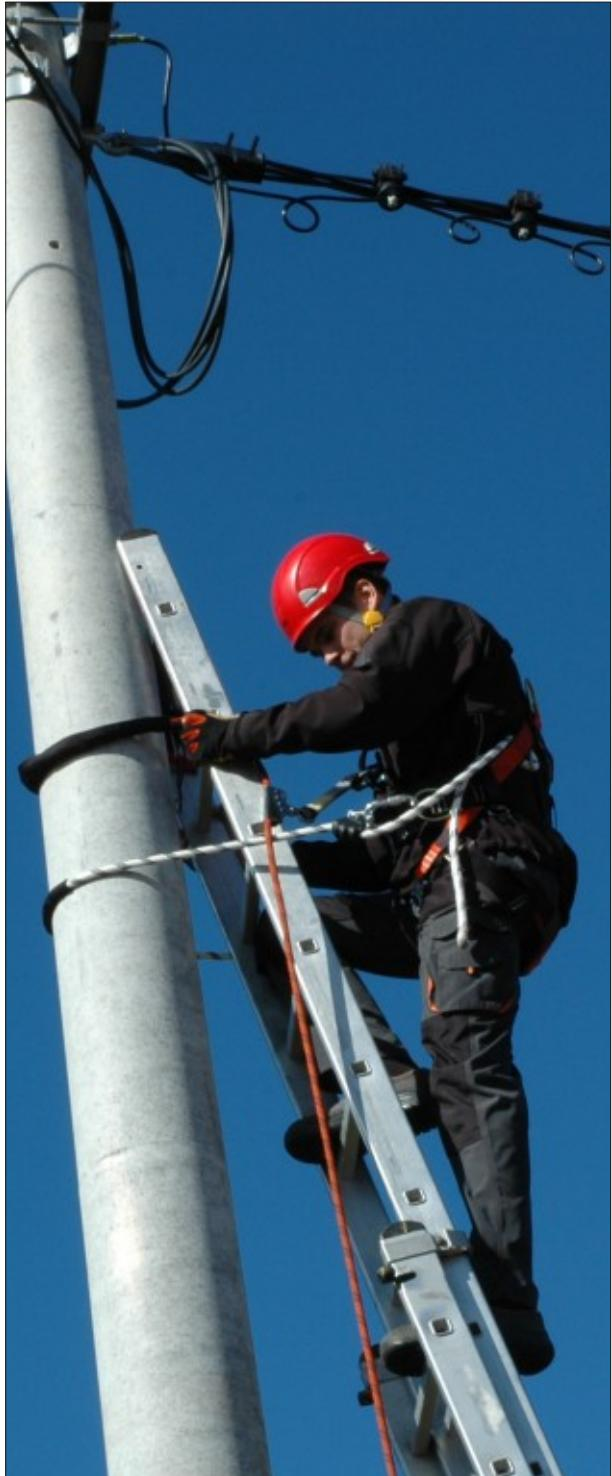
Лямочный пояс, строп для позиционирования,, ленточный зацеп, самозажимная система защиты от падения и петля, опоясывающая столб
