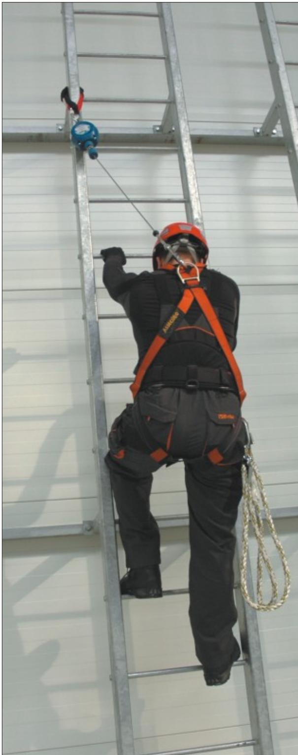
Лямочный пояс, зацеп ленточный, самотормозное устройство
