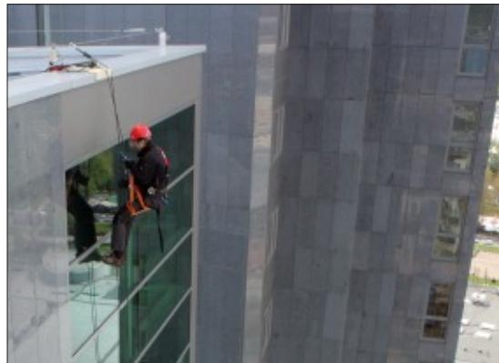
Обязательным правилом выполнения таких работ является использование двух веревок. Одна для подъема, спуска и позиционирования в месте проведения работ, а другая для страховки.
