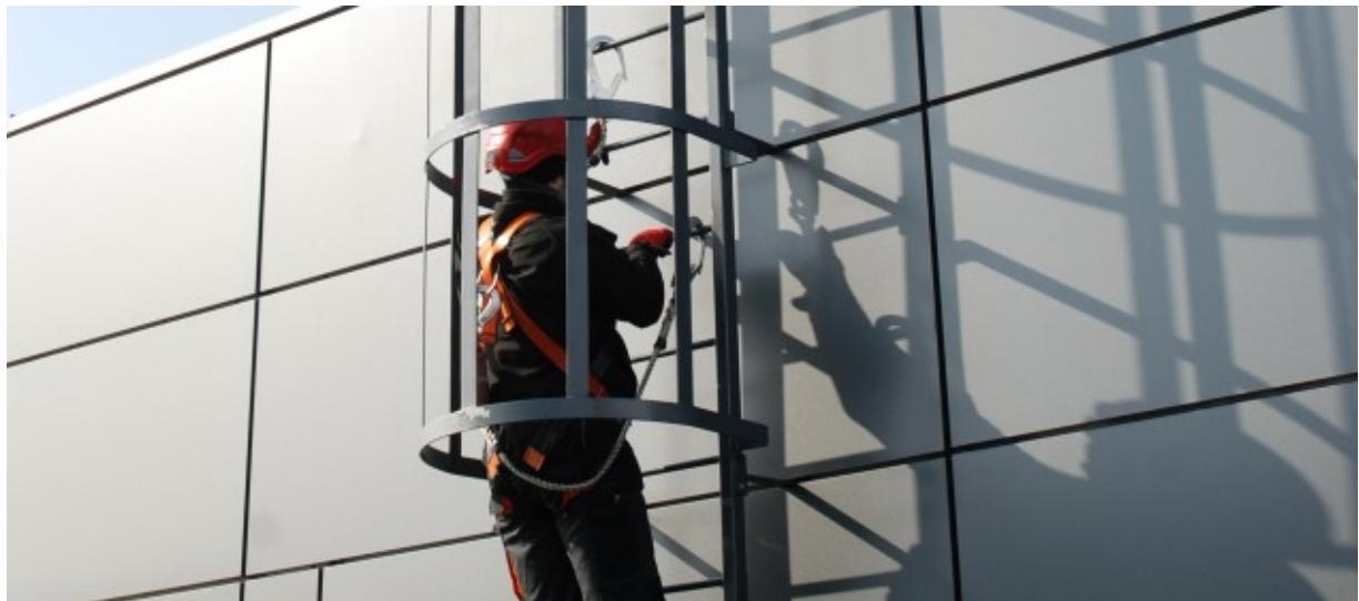
Лямочный пояс, строп для позиционирования, двойной строп с амортизатором, применение при подъеме по лестнице
