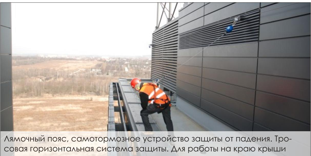
Лямочный пояс, самотормозное устройство защиты от падения. Тросовая горизонтальная система защиты. Для работы на краю крыши
