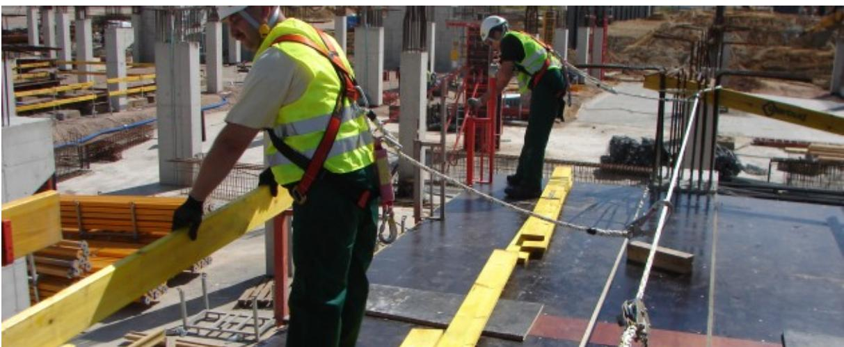
Лямочный пояс, страховочный, регулируемый строп, амортизатор с дополнительным карабином, канатная система защиты HARIP
