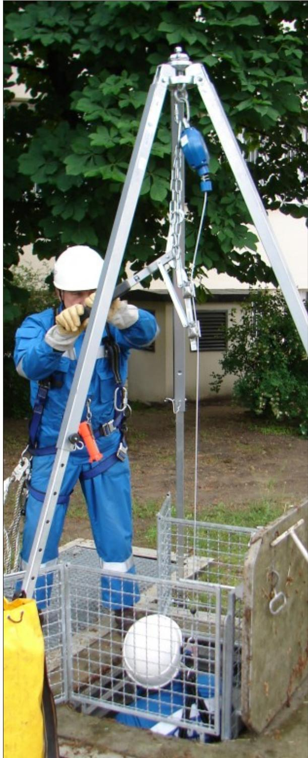
Лямочный пояс, трипод спасательный, самотормозное устройство, ручная лебедка.
