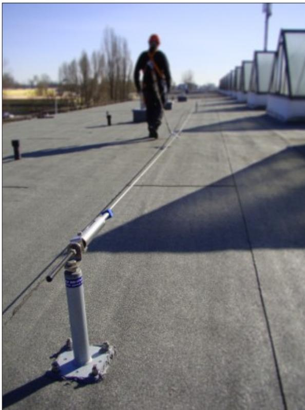
1. столбик STABIL - крепится шлямбурами к бетону или болтами к стальному швеллеру. Выполняет функции конечных и промежуточного пунктов крепления.
