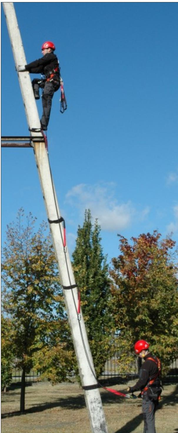
Лямочный пояс, строп для позиционирования, веревка динамическая, зацепы ленточные, снаряжение для подъема с нижней страховкой
