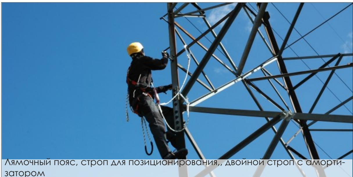
Лямочный пояс, строп для позиционирования, двойной строп с амортизатором
